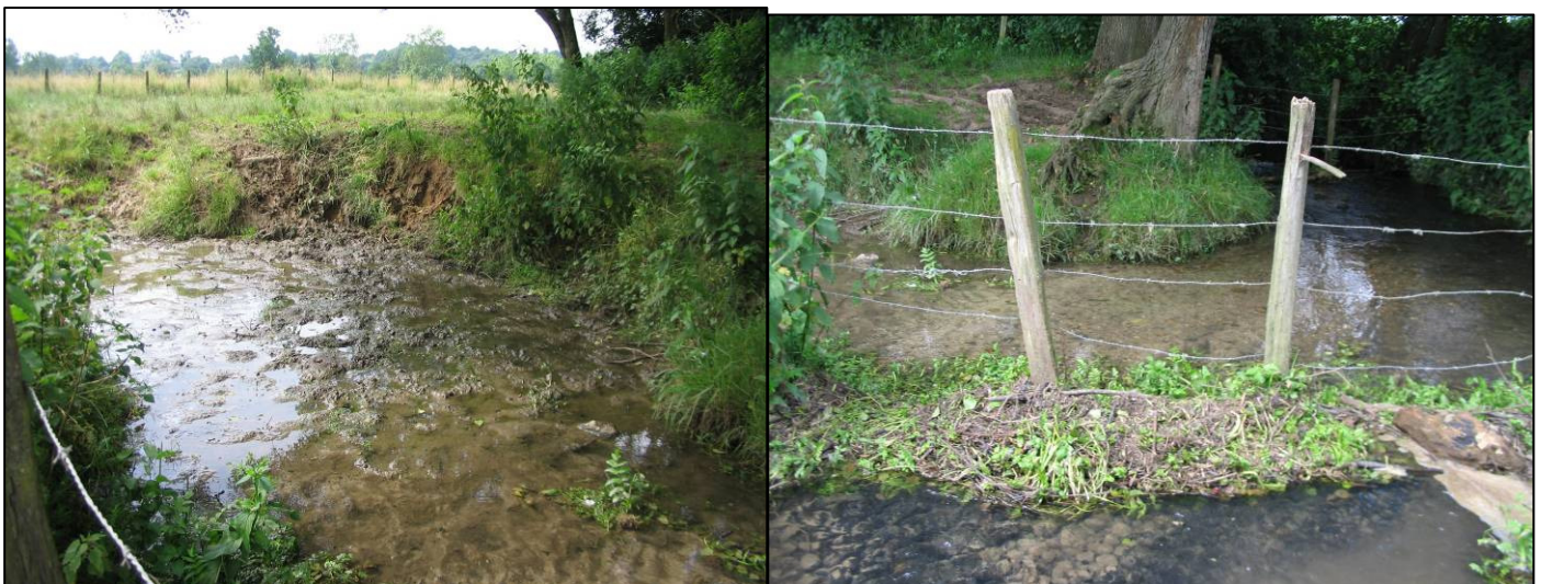
Figure : état actuel de l'abreuvoir :
