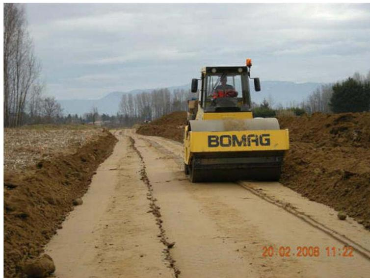
Exemple de réalisation : compactage des fondations sur emprise du corps de digue
