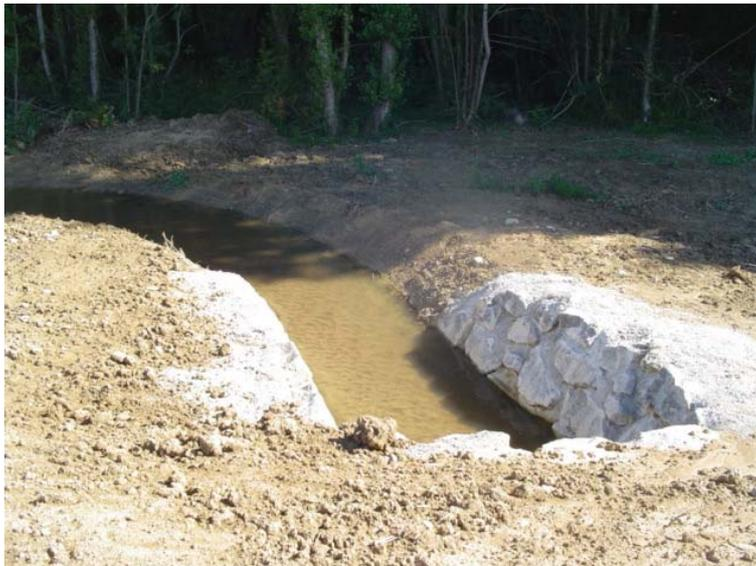
*Exemple de réalisation : pertuis (dalot calibré) dans le corps d'une digue, permettant le passage d'un cours d'eau (continuité hydraulique)*
