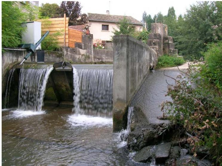
*Guereins : pelle électrique régulant les niveaux d'eau dans la Calonne*
