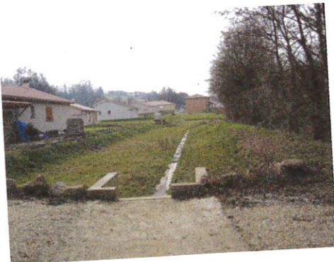
Lotissement construit en zone humide (Genouilleux)
