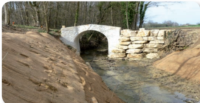
Replantations sur l'Avanon au pont du basson
