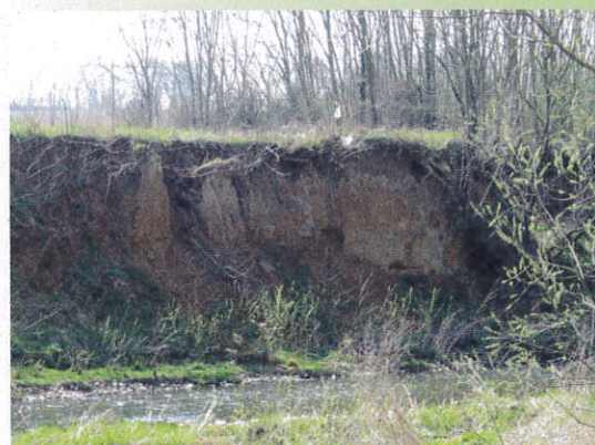
Erosion de berge sur la Chalaronne
